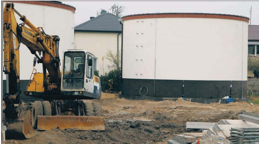
Rozbudowywana stacja uzdatniania wody przy ul. Żeromskiego w Piasecznie
